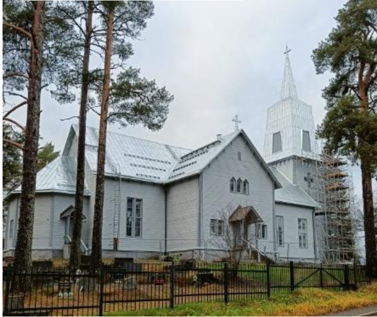
Polvijärven kirkon vesikattoremontti 2025
